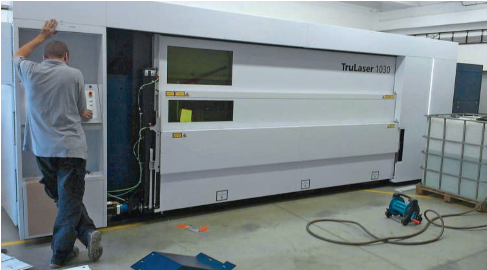
Inštalácia 3D laserového rezacieho stroja.
